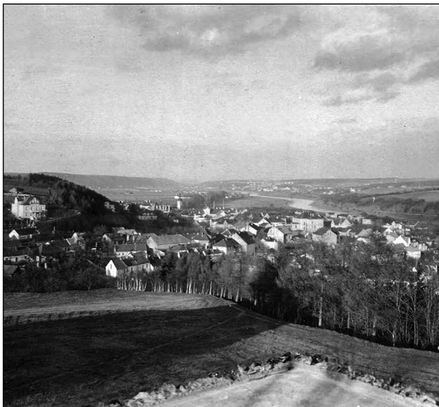
Pohled od vodojemu (sirény) okolo 1927
